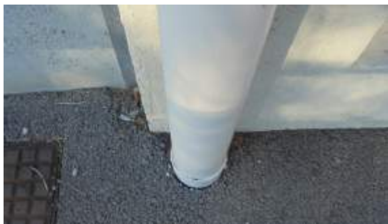
Exemple d'une descente de cheneau hermétique
