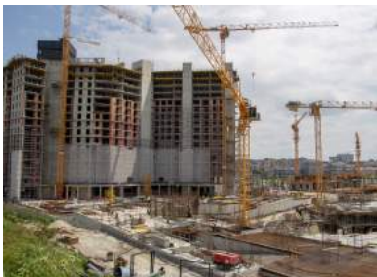
Chantier de construction
